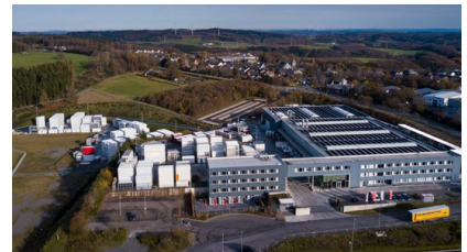
Werksgelände in Lichtenberg – auf der Freifläche links entsteht ab 2023 die neue Produktionshalle.
