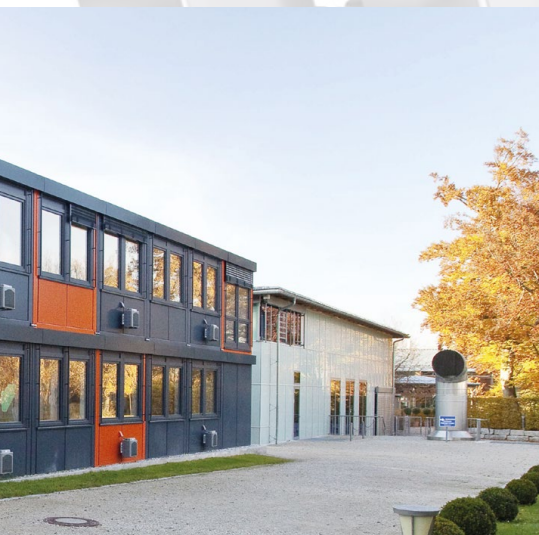
Die Baureihe ProEnergy erfüllt die gesetzlichen Normen der EnEV unter anderem durch energetisch optimierte Fensterkonstruktionen mit niedrigen Wärmedurchgangskoeffizienten und Isolierverglasung.
